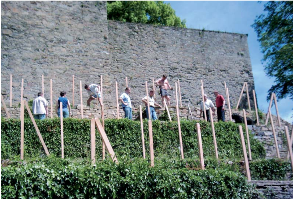
Errichtungsarbeiten durch Mitglieder des Bürgervereins Wesselbach im Mai 2005
