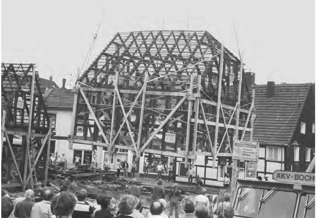
Temporäre Umsetzung der heutigen Gaststätte „Olive“ an der Gaußstraße auf die Fläche des heutigen Marktplatzes. Foto: Widbert Felka, 4. August 1983
