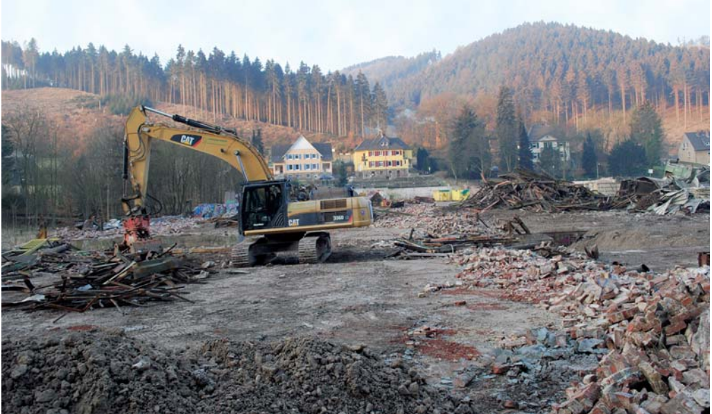
Abrissarbeiten auf dem Gelände des Krupp-Werkes IV. Eine neue Perspektive mit Blick auf den Hobräcker Weg eröffnet sich. Foto: Volker Bremshey, WESTFALENPOST, 31. Januar 2012
