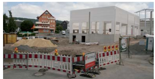
Nach dem Abriss der EGA-Fabrikgebäude wächst an der Lindenbergstraße der Rohbau des Rewe-Einkaufszentrums in die Höhe (Blick von der Brauhausstraße). Foto: Widbert Felka, 29. Juni 2008
