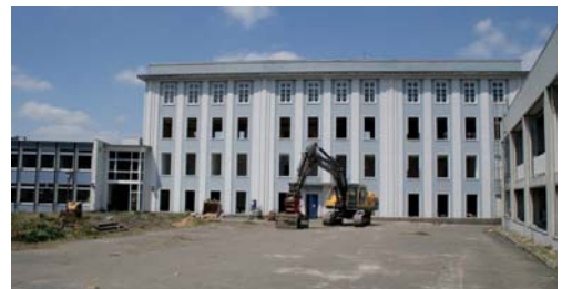
Das Elsey jahrzehntelang prägende Fabrikgebäude am Stift zu Beginn der Abrissarbeiten. Foto: Widbert Felka, 29. Juni 2008
