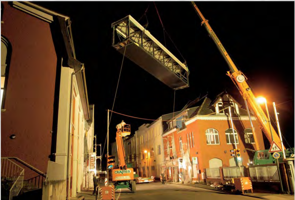
Nächtlicher Einsatz: Brückenverbindung der beiden Gebäude der Wilhelm-Busch-Schule an der Obernahrmer Straße 9 und 12 (ehemalige Krupp-Gebäude). Die neue Verbindung ist 7,5 Tonnen schwer. Foto: Christian Rasche, WESTFALENPOST, 22. August 2010
